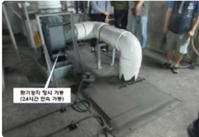
그림4 지하철 펌프장 외부 공기 공급시설 설치 예
