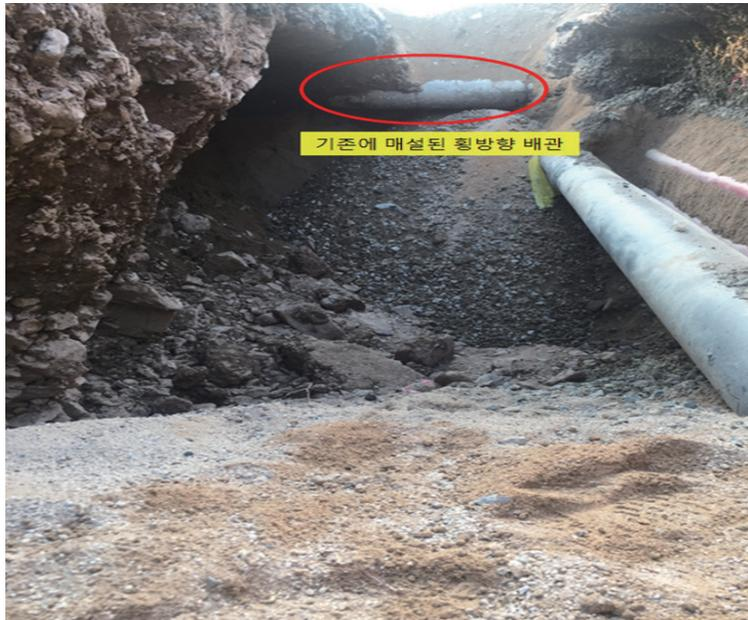
[사진2] 횡방향 배관 매설 전경(기존 매설배관의 영향으로 붕괴에 취약)
