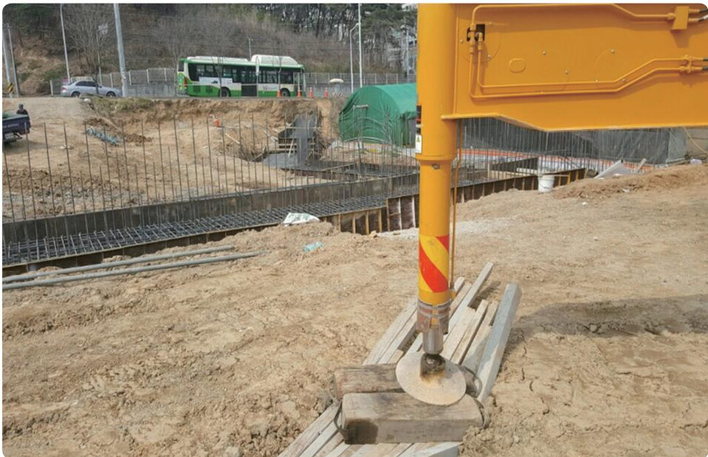
[사진 2] 좌측 아웃트리거 설치 지반 침하상태
