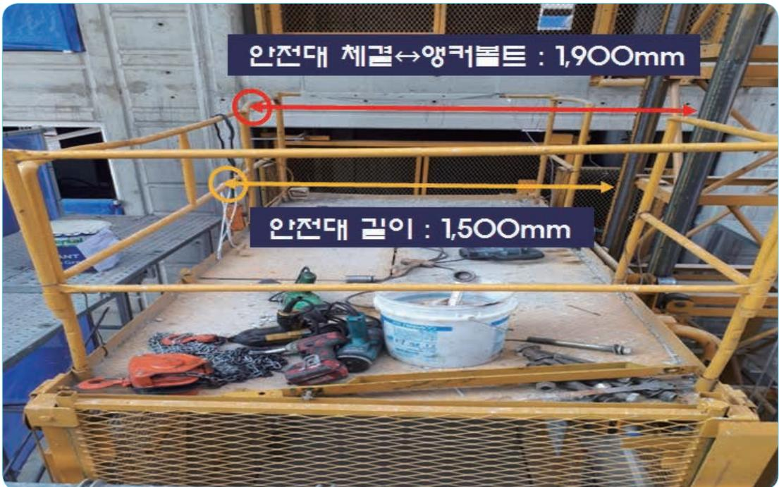
[사진2] 안전대 체결한 위치부터 앵커볼트까지의 길이와 재해자가 착용한 안전대의 길이(400mm차이)
