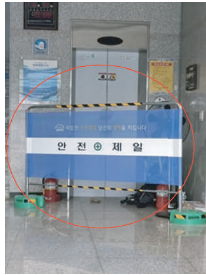
승강장에 직원, 작업자, 외부인 등 진입을 차단하는 안전휀스 설치
