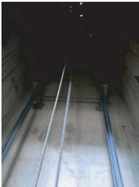
고소작업 시 카 외측 공간(개구부)으로 떨어짐 위험, 내부 조명 미확보
