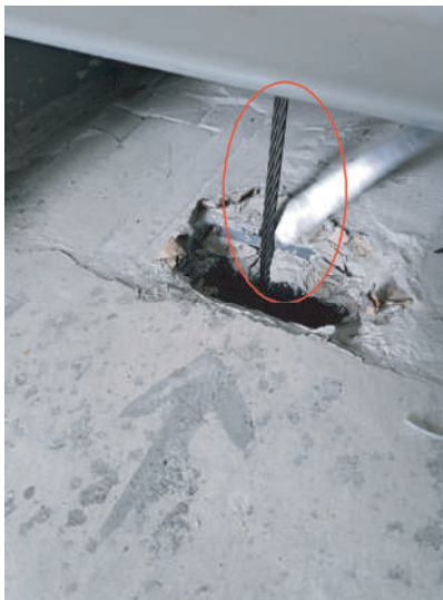
승강기 매단 원치의 와이어로프 절단으로 승강기 낙하 위험
