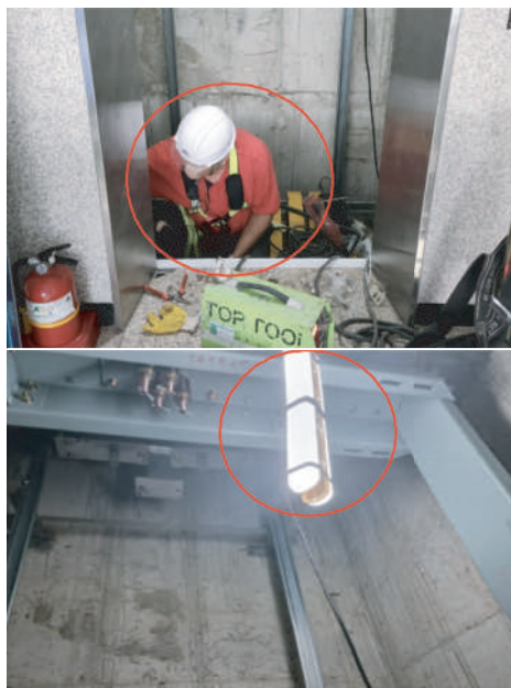
안전대를 카의 견고한 구조물에 고정된 상태에서 고소작업 실시, 피트 내부 조명 확보
