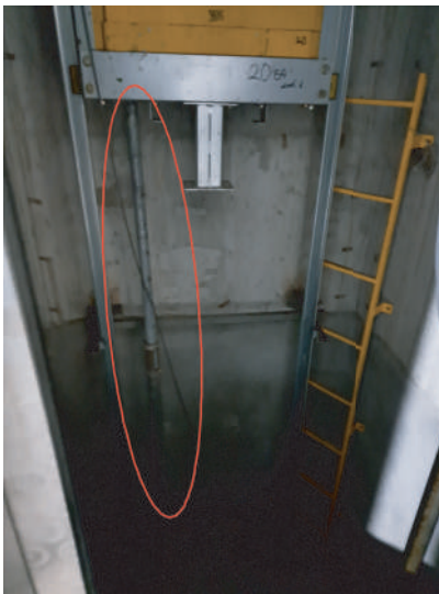
균형추 하부 지지용 서포트 부족으로 서포트 좌굴 및 균형추 낙하 위험
