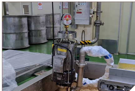
모노펌프용 크레인 사용
