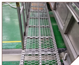
설비 점검용 통로 설치
