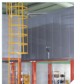
고정사다리 등받이울 설치
