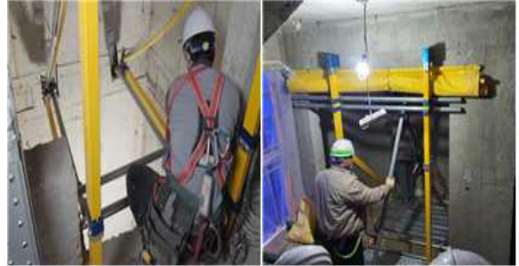
<엘리베이터 승강로 외부에서 설치>
